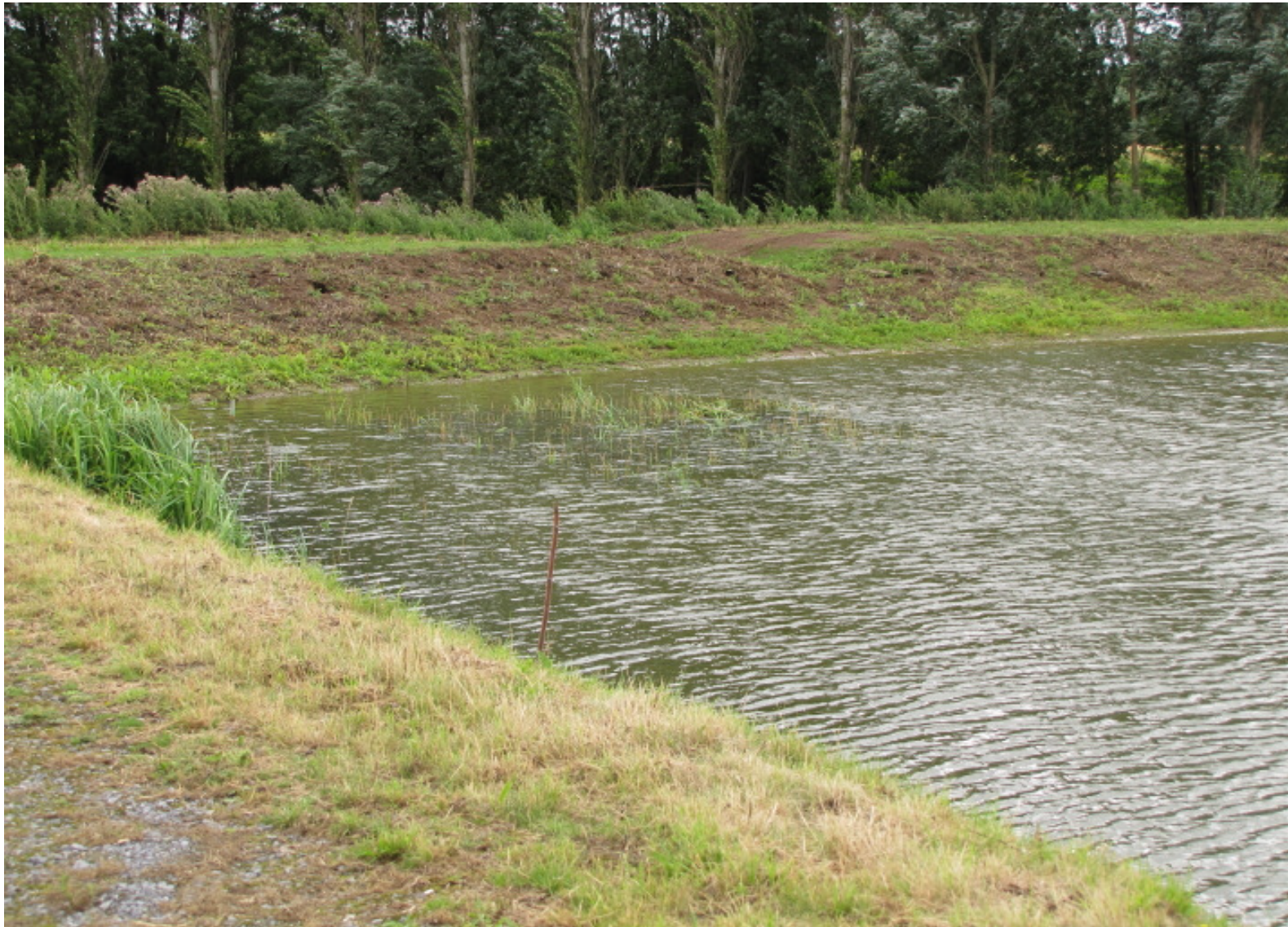
Bassins d'orage avec berges en pentes douces
