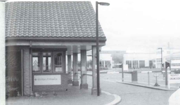
Contrôle à l'entrée du site
