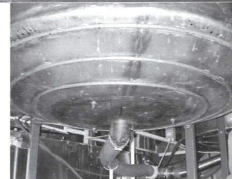
Dessous de cuve d'un extracteur sous laquelle on voit le serpentin chauffant.
