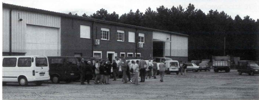
Photo 2 : Vue générale des bâtiments de la coopérative EL BREZAL (Photo E. Bruneau)
